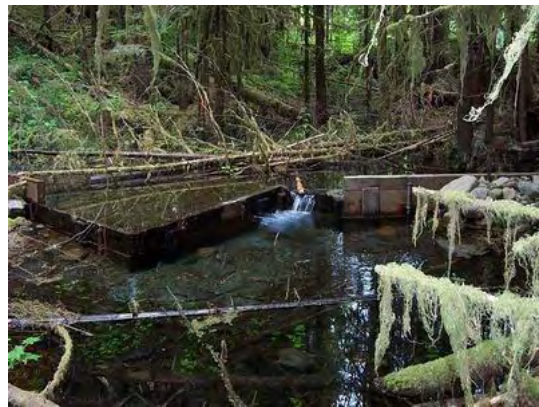
(d) Plank Zig-zag weir. Lear Springs.
